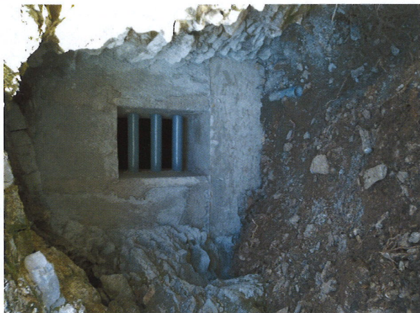
Photo 8. Mise en sécurité d'une galerie par création d'un mur béton avec accès pour chiroptères (photo MICA Environnement).
